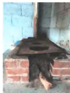
Foto 4: Sustitución de estufa rural con chimenea, plancha y accesorios.
