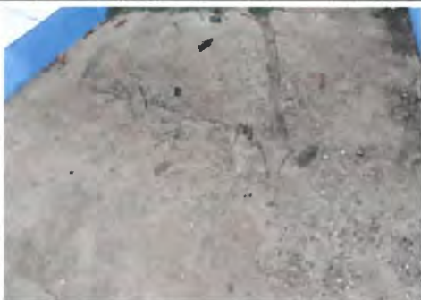
Foto 3: Reparación de losa de concreto para patios, considerando preparación de terreno, armado, nivelación y acabado rustico.
