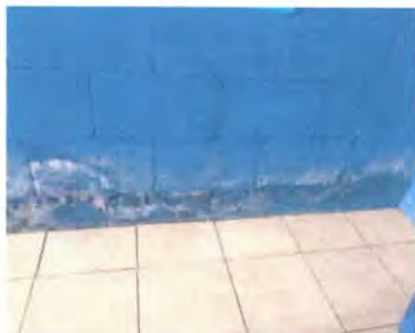
Foto1: Preparación de la superficie y aplicación de pintura a dos manos, en paredes interiores y exteriores del establecimiento.
